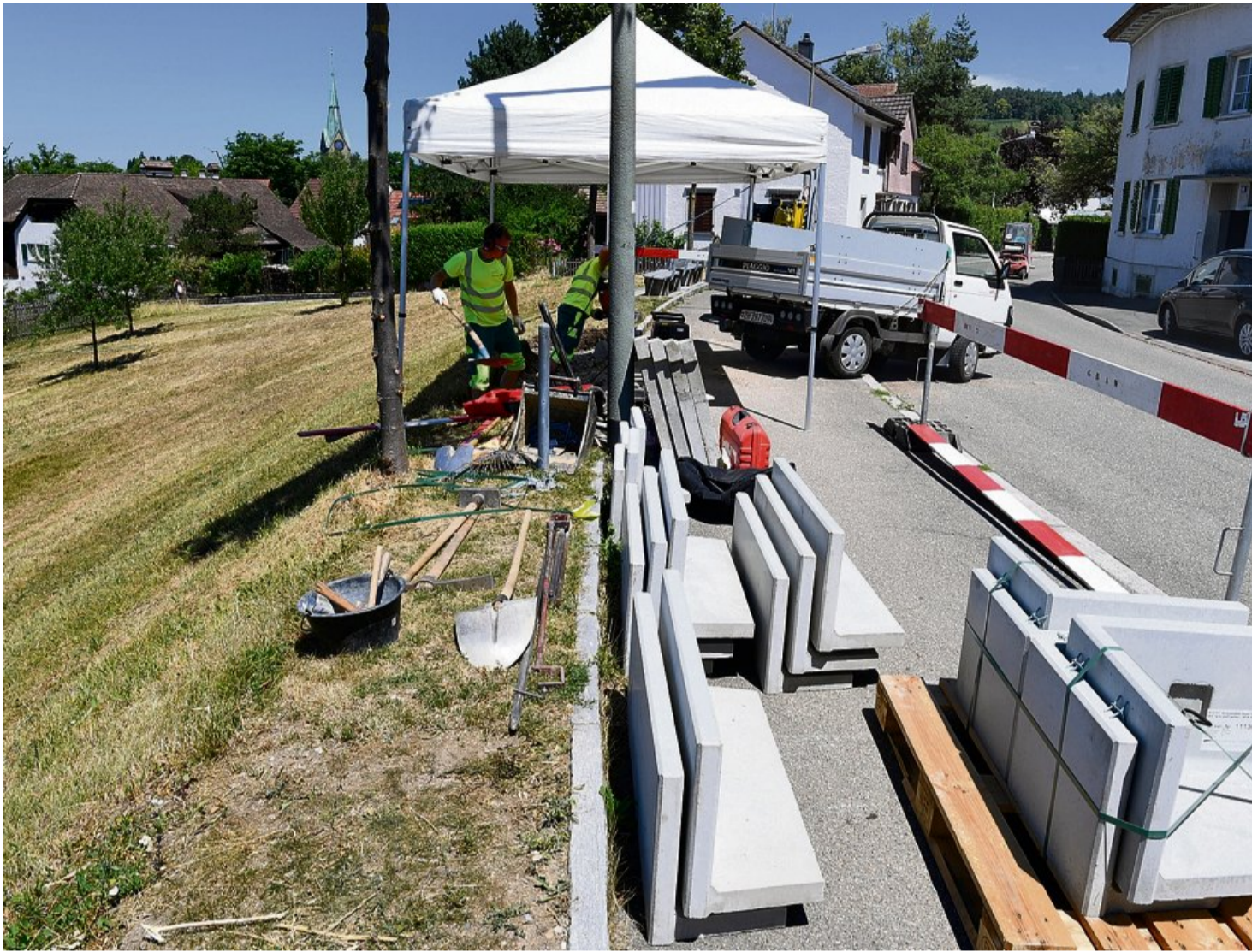
Vier Bänke waren weg, nun kehren zwei zurück: Gestern wurden ob der Schenkelwiese in Wülflingen die Fundamente gelegt.
